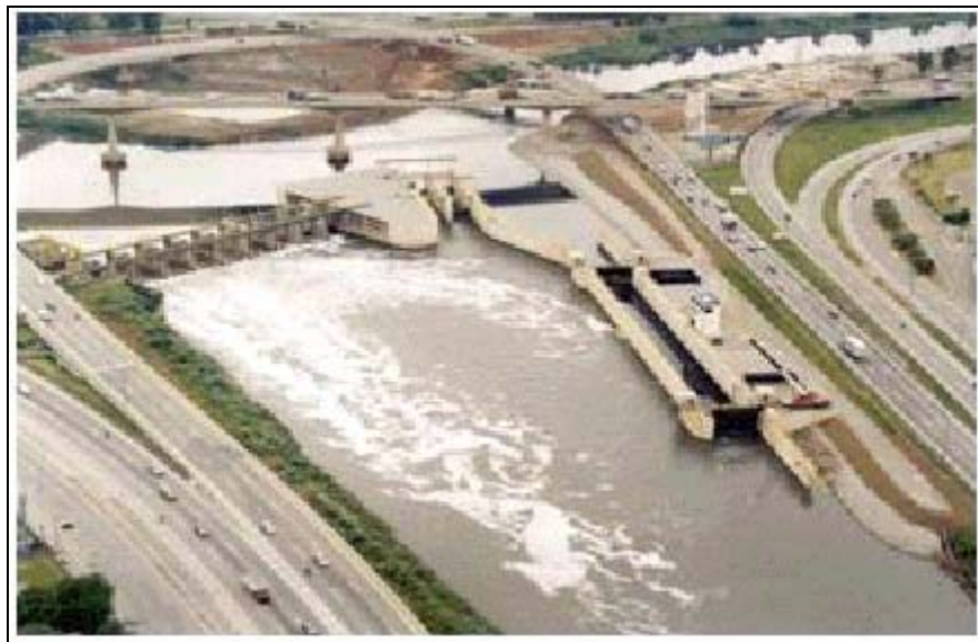
Figura 15: Eclusa Barragem do Cebolão Fonte: Secretaria dos Transportes de São Paulo (2006)
