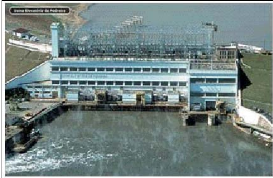
Figura 13: Barragem Usina Elevatória da Pedreira Fonte: Secretaria dos Transportes de São Paulo (2006)
