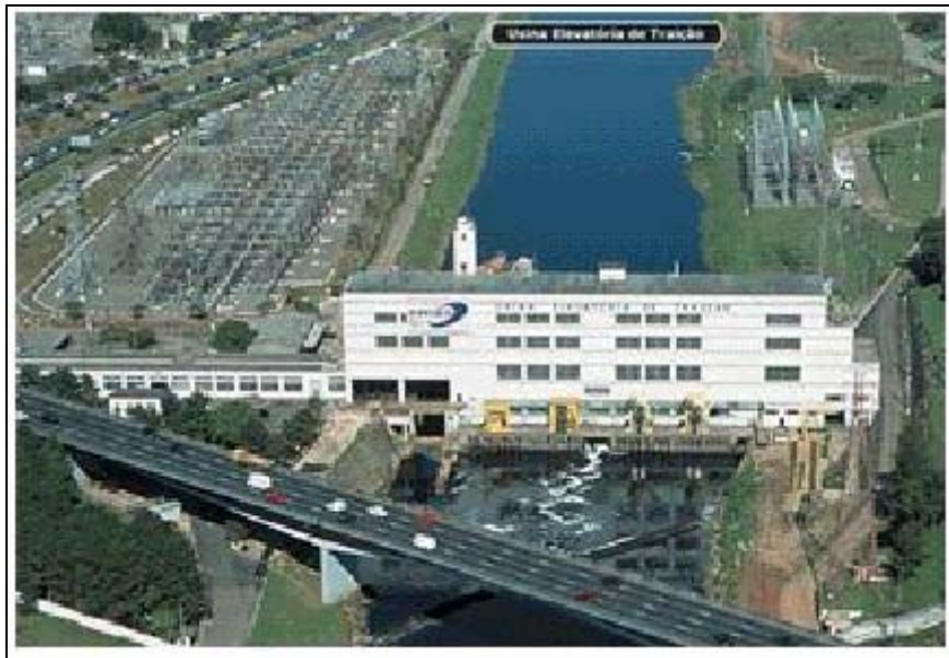
Figura 12: Barragem da Usina Elevatória de Traição Fonte: Secretaria dos Transportes de São Paulo (2006)
