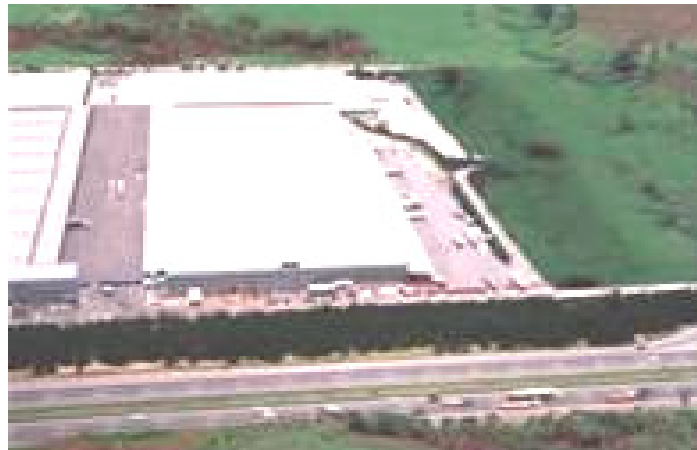
Figura 6: Centro de Distribuição de Barueri (Mclane)
