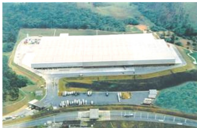
Figura 5: Centro de Distribuição em Anhanguera (Mclane).
