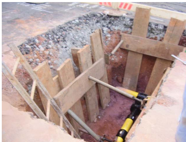
Figura 1 – Abertura de vala na rua
