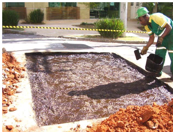
Figura 8 - Execução da camada de imprimação betuminosa ligante
