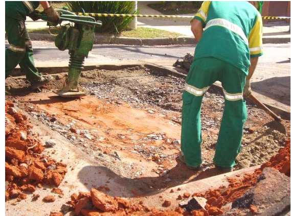
Figura 6 – Recompactação do solo
