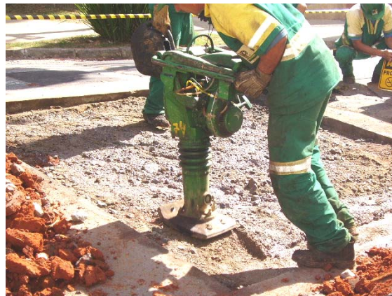
Figura 7 – Compactação da camada BGS
