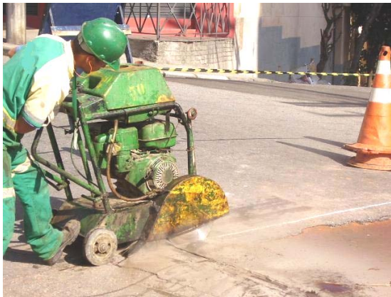
Figura 5 – Corte do pavimento
