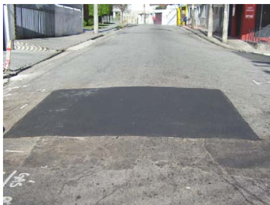
Figura 11 – Pavimento final após a recomposição
