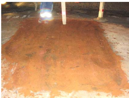
Figura 3 – Situação final do solo compactado
