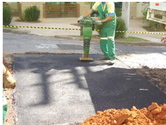
Figura 10 – Final da compactação da camada de binder
