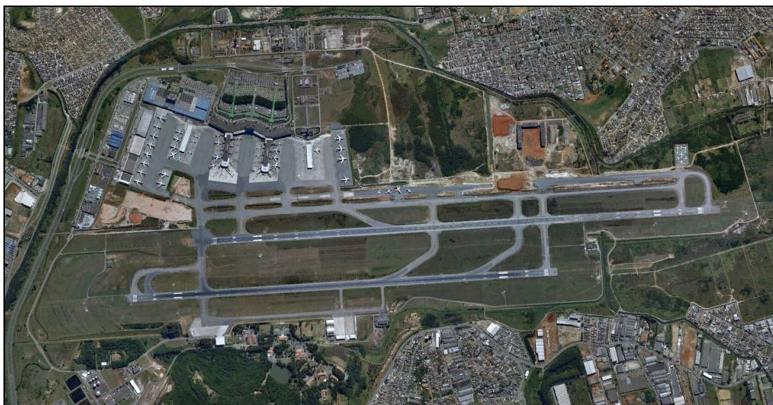
Figura 3 - Foto aérea do aeroporto de Guarulhos (Google Earth, 2010)
